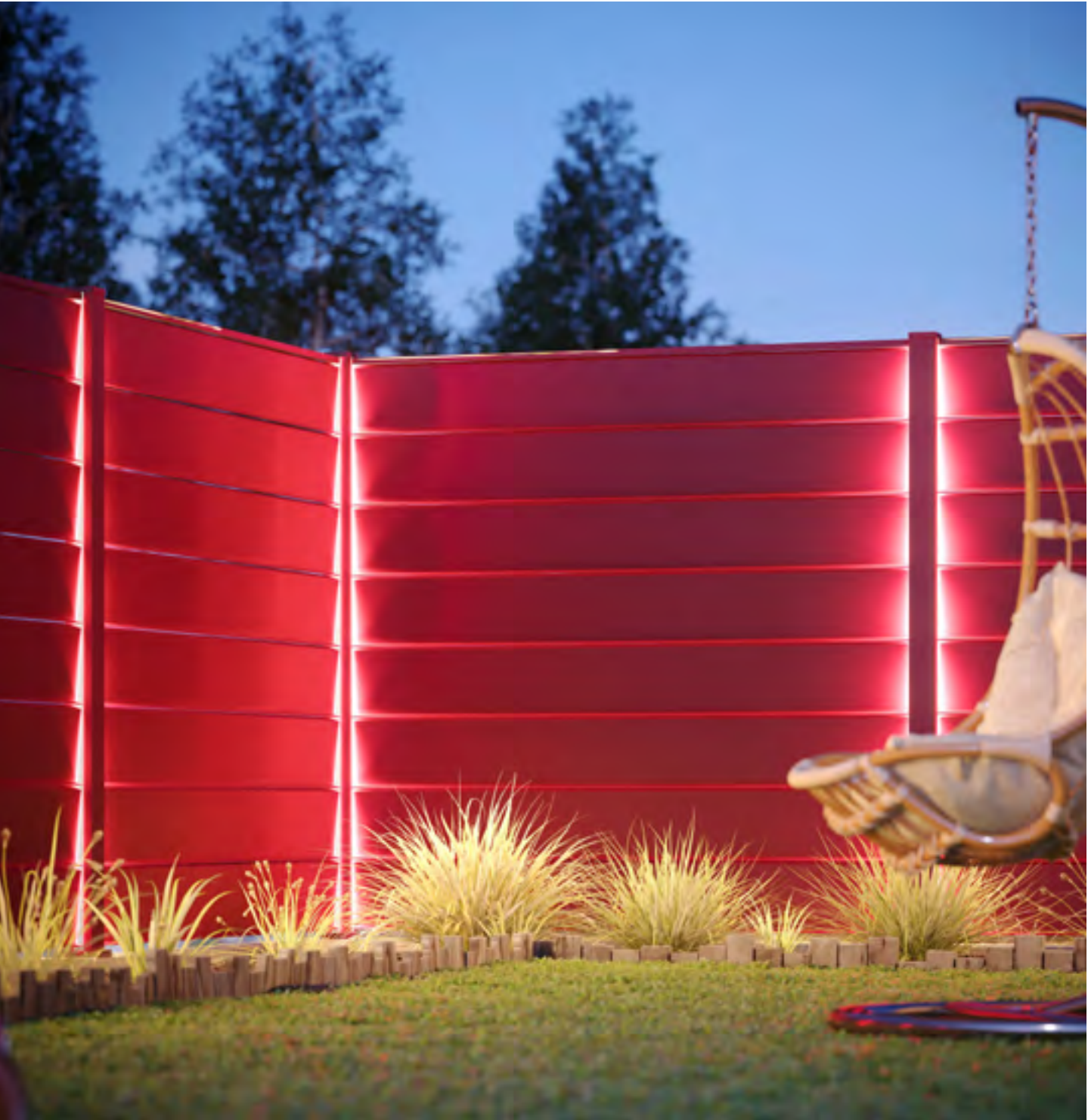
CLAIRE-VOIE / CLAUSTRA Lames claire-voie. Éclairage LED dans les poteaux.
