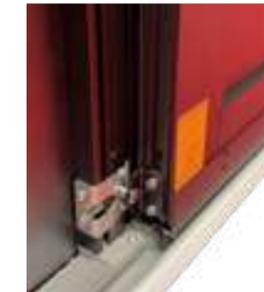
Sécurité Point de verrouillage côté refoulement.
